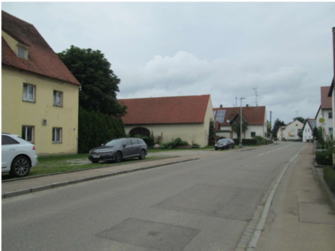
Abb. 2: Aufnahme vom 28.07.2021, Blick entlang der Sonnenhamer Straße nach Norden, ehem. Gasthaus Alter Wirt mit Nebengebäude (zwischenzeitlich abgerissen) und Hofbaum links der Straße
