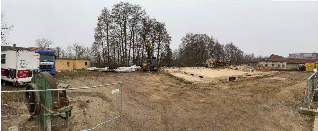
Abb. 3: Aufnahme vom 01.03.2024, Blick von Südosten nach Nordwesten über das zwischenzeitlich geräumte Plangebiet, erhaltener prägender Gehölzbestand entlang der Weilach im Bildhintergrund
