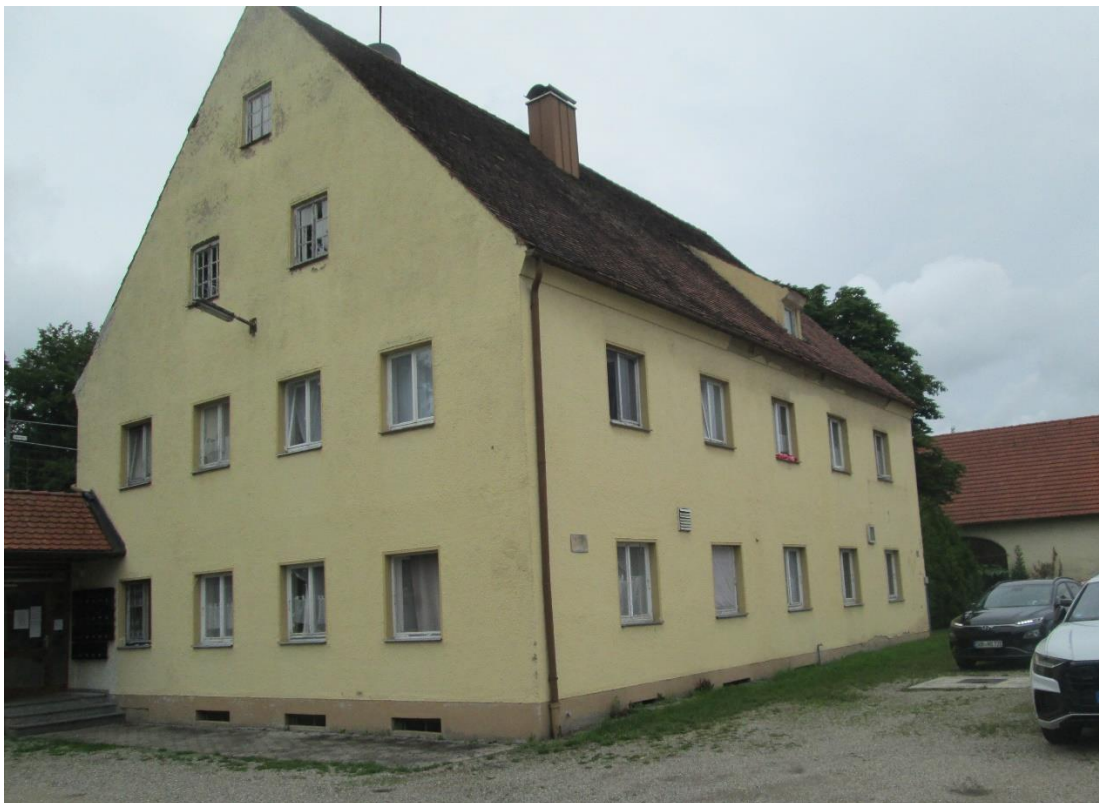
Abb. 3: Wohnhaus vor Abbruch (Aufnahme: 28.07.2021)
