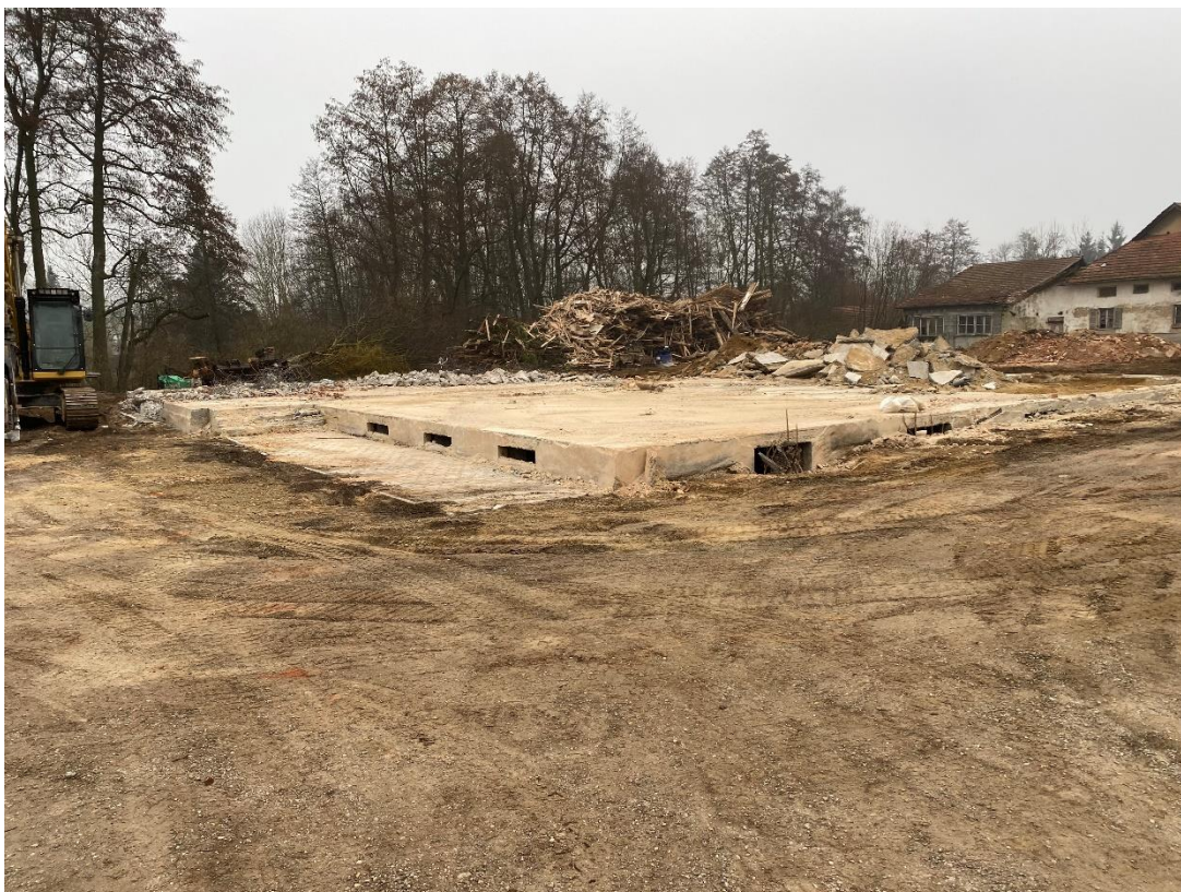
Abb. 5: Planungsgebiet nach Abbruch und Fällung (Aufnahme: 01.03.2024)
