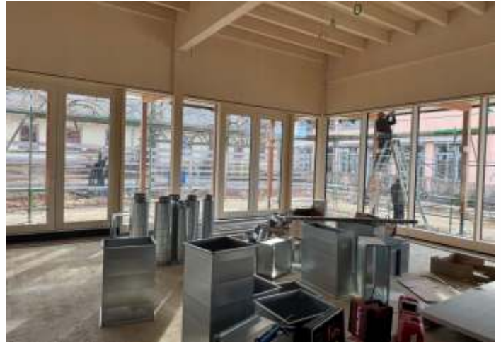
Im Pavillon wird die Lüftung montiert.
