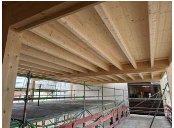
Der Verbindungsbau zwischen alter Schule und neuem Anbau wird erstellt.
