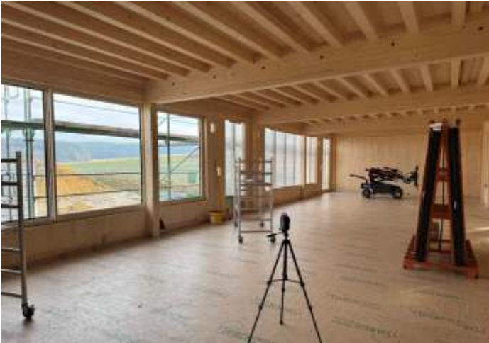
Die Fenster werden gesetzt.
