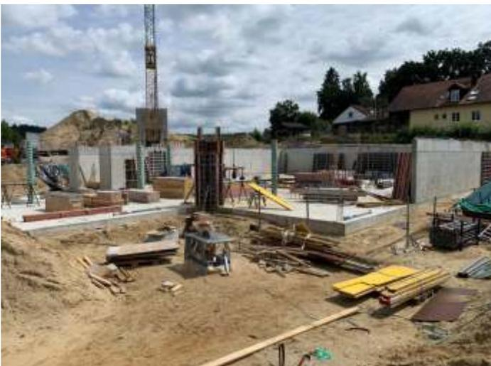
Die Bodenplatte und die Seitenwände des Erweiterungsbaus wurden betoniert.
