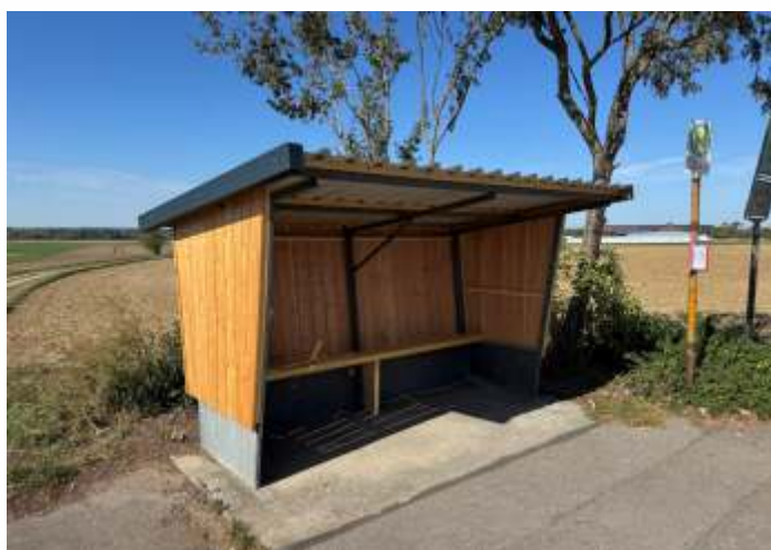
An der Bushaltestelle Rosensteig wurde ein neues Buswartehäuschen errichtet.
