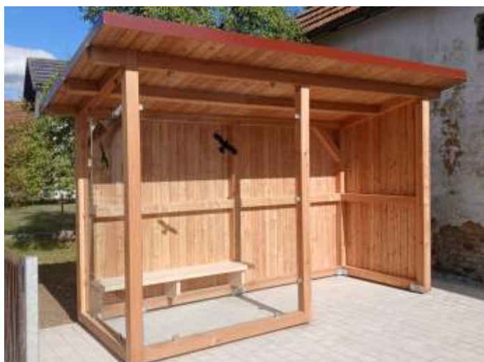
An der Bushaltestelle Sonnenhamer Str. wurde ein neues Buswartehäuschen errichtet.
